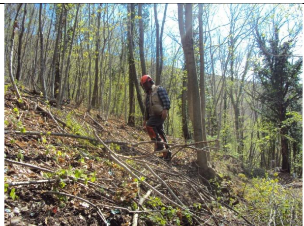
Operai al lavoro nella UdS C17-2
